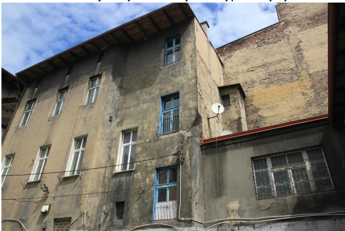
Rys. nr 7. Widok elewacji południowo-wschodniej budynku przy ul. Dworcowej 21 w Bytomiu – elewacja od strony podwórza [1.3.]
