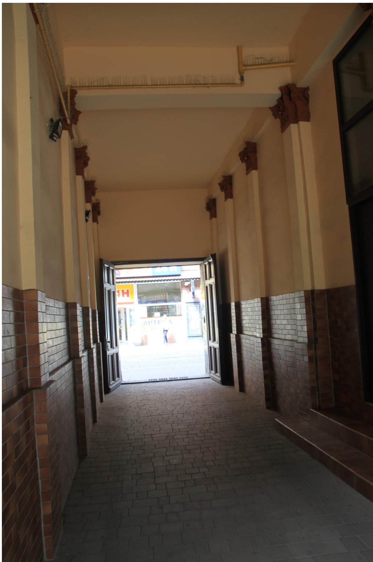
Rys. nr 12. Widok przejazdu pod budynkiem. [1.4.]
