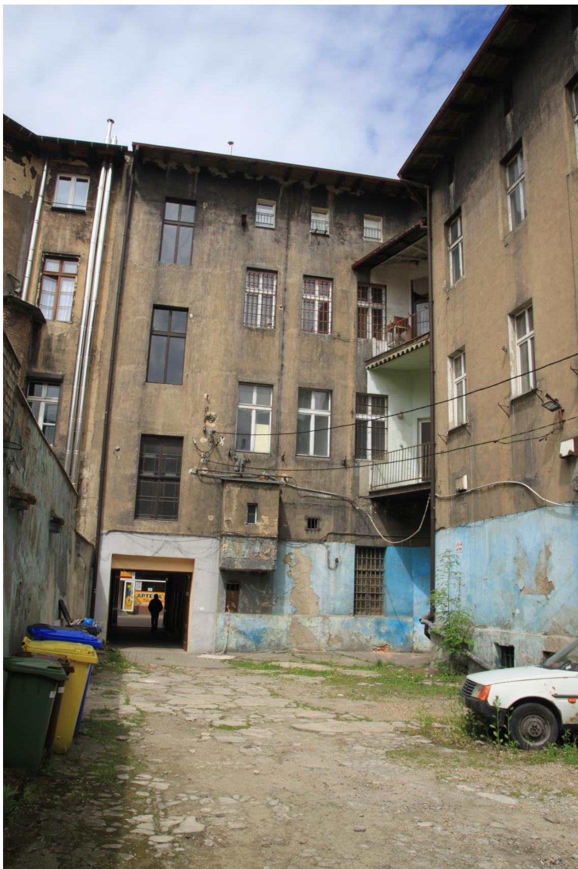
Rys. nr 4. Widok elewacji od strony podwórza budynku przy ul. Dworcowej 21 w Bytomiu – elewacja południowo-wschodnia i południowo-zachodnia [1.3.].
