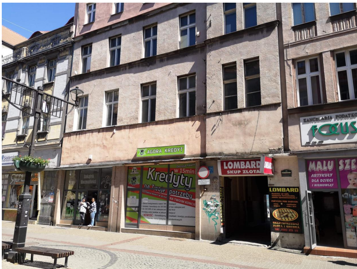
Rys. nr 32. Ściana frontowa północno-zachodnia, od strony ulicy Dworcowej [1.3.].
