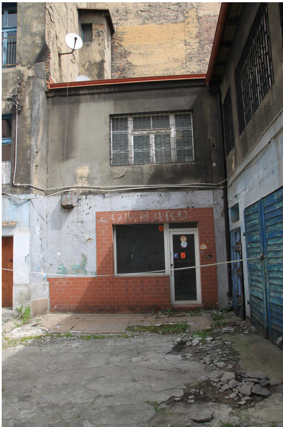
Rys. nr 9. Widok elewacji południowo-wschodniej, budynku przy ul. Dworcowej 21 w Bytomiu – elewacja od strony podwórza [1.3.]
