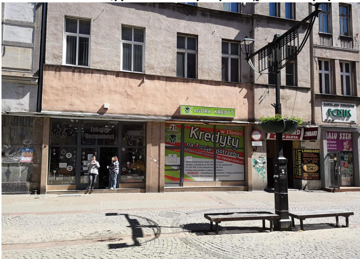
Rys. nr 17. Brak estetyki elewacji frontowej [1.3.].
