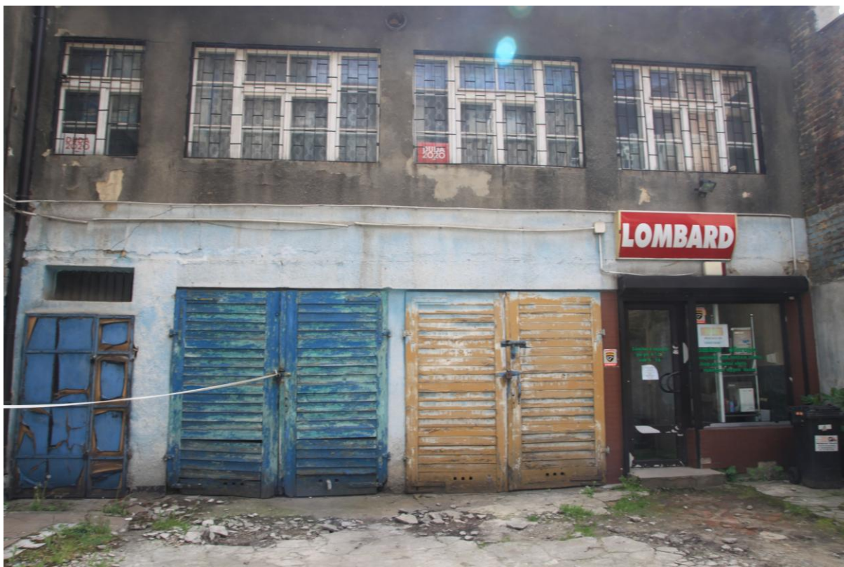
Rys. nr 10. Widok elewacji północno-zachodniej budynku przy ul. Dworcowej 21 w Bytomiu – elewacja od strony podwórza [1.4.]
