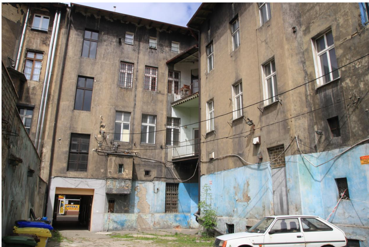
Rys. nr 6. Widok elewacji południowo-wschodniej, południowo-zachodniej budynku przy ul. Dworcowej 21 w Bytomiu – elewacja od strony podwórza [1.3.]
