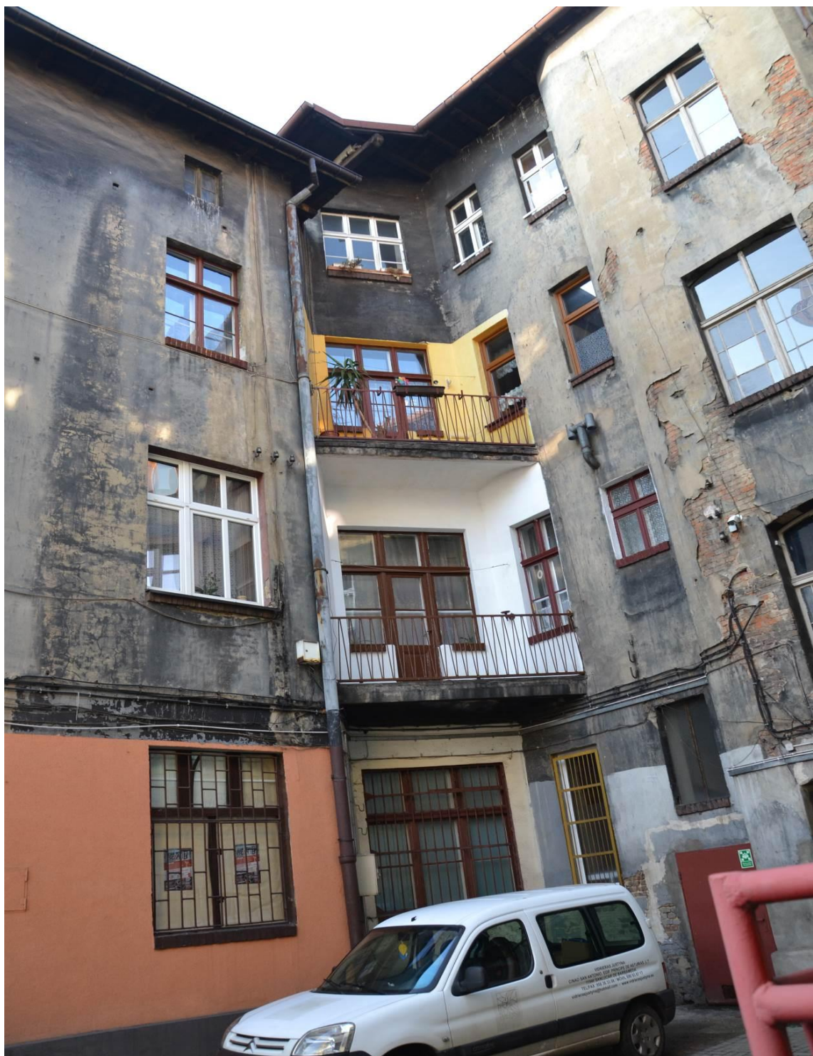
Rys. nr 9. Widok elewacji południowo-wschodniej, północno-wschodniej budynku przy ul. Dworcowej 31 w Bytomiu – elewacja od strony podwórza [1.3.]
