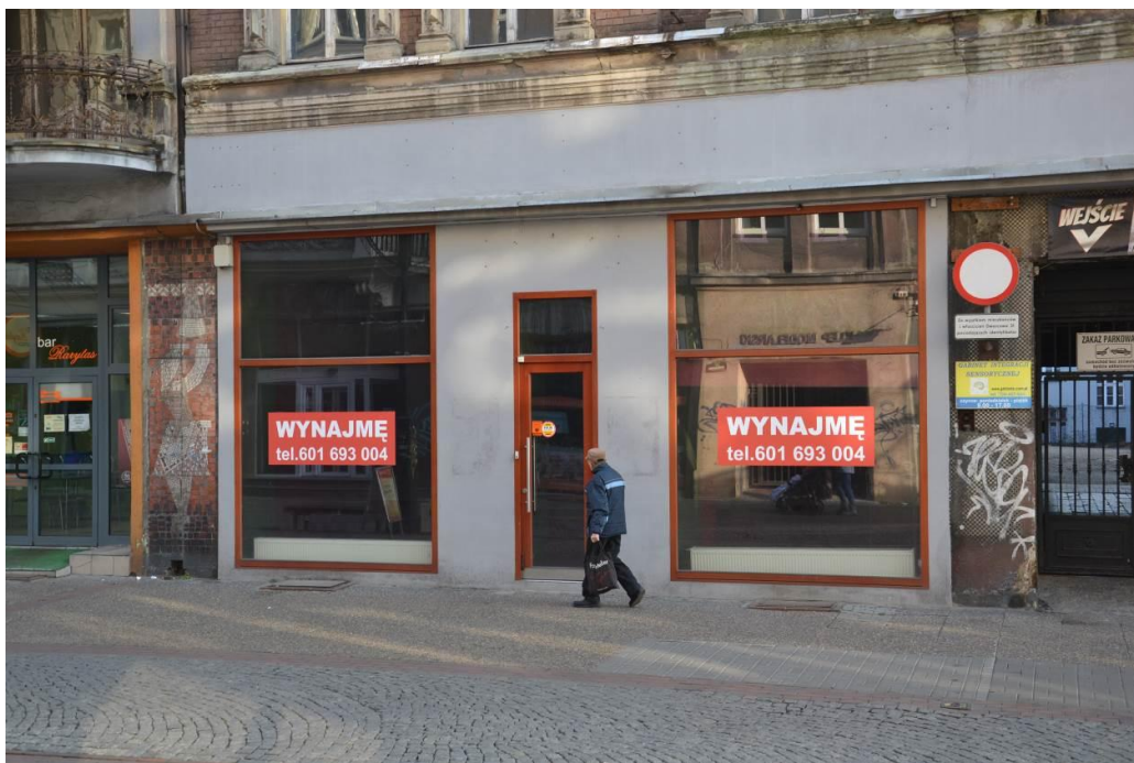
Rys. nr 16. Zabrudzenia na powierzchni ścian. Spękania, odparzenia i ubytki tynku w obszarze gzymsu, korozja obróbek blacharskich, jej odkształcenia [1.3].
