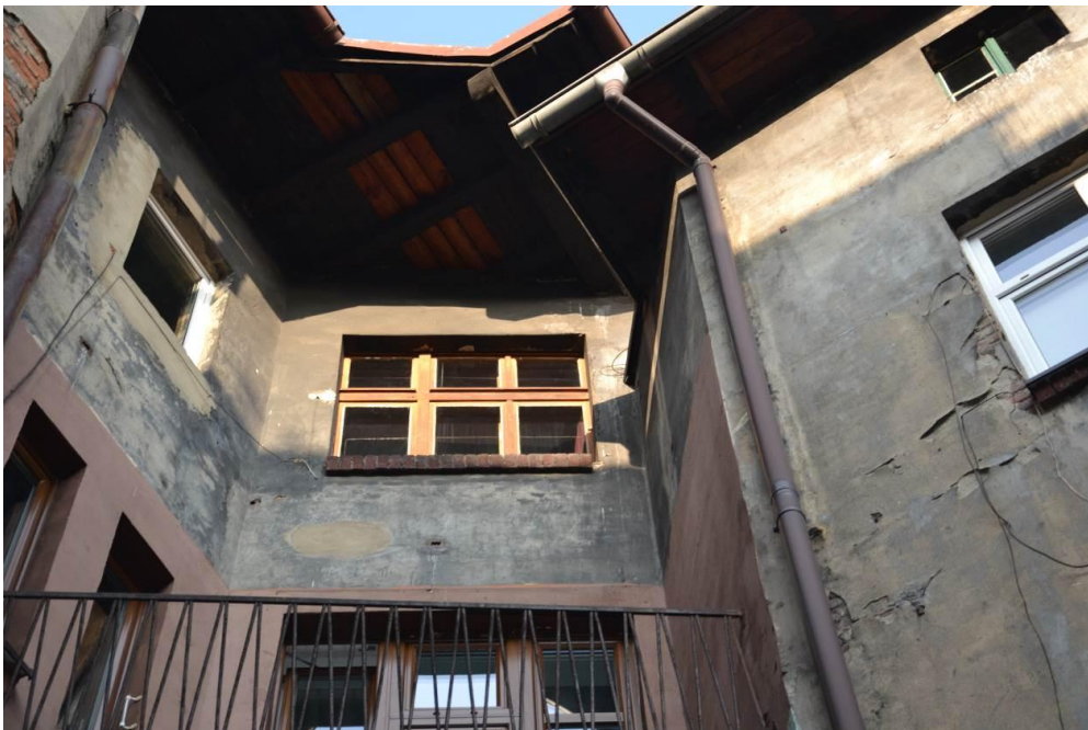
Rys. nr 26. Odparzenia tynku, miejscowe wypłukanie zaprawy cementowej z muru, korozja obróbek i stalowych belek płyty balkonowej, zacieki na elewacji, brak estetyki [1.3].
