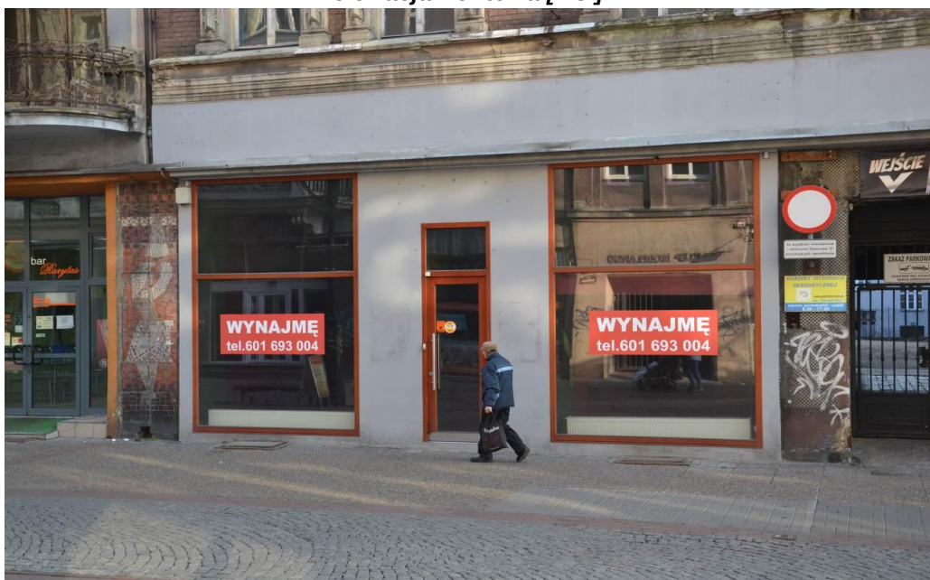
Rys. nr 4. Widok elewacji północno-zachodniej budynku przy ul. Dworcowej 31 w Bytomiu – elewacja frontowa, część usługowa [1.3.].
