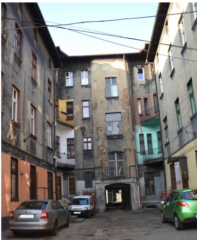
Rys. nr 6. Widok elewacji południowo-wschodniej, północno-wschodniej budynku przy ul. Dworcowej 31 w Bytomiu – elewacja od strony podwórza [1.3.]
