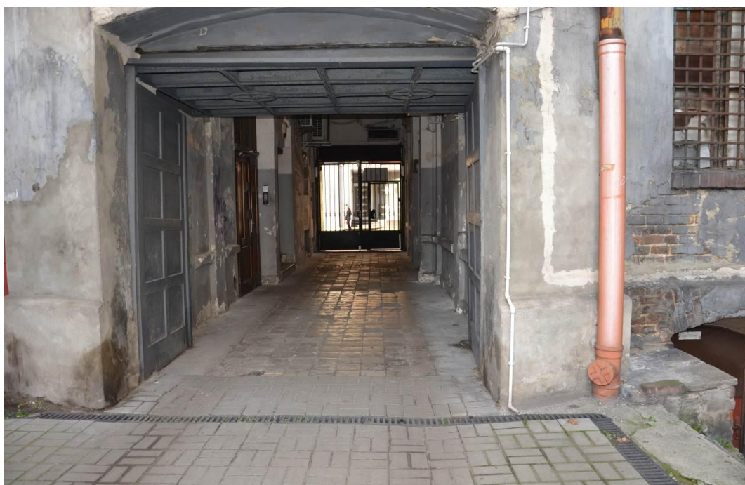
Rys. nr 8. Widok przejazdu pod budynkiem przy ul. Dworcowej 31 w Bytomiu [1.3.]
