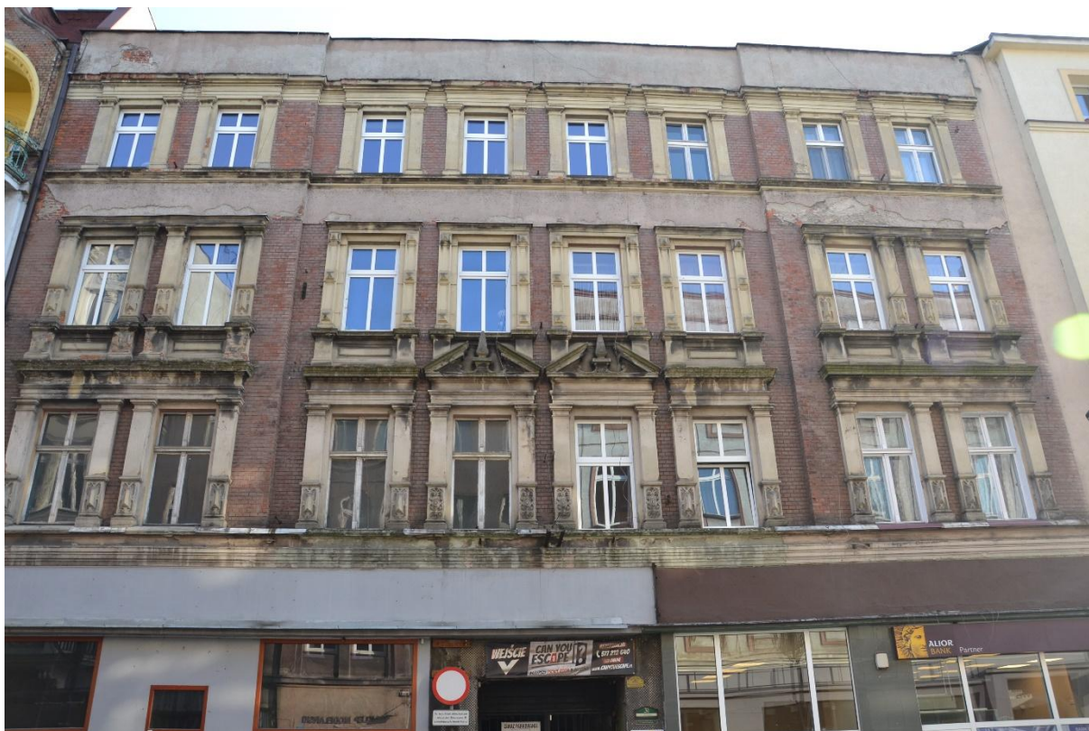
Rys. nr 32. Ściana frontowa północno-zachodnia, od strony ulicy Dworcowej [1.3.].
