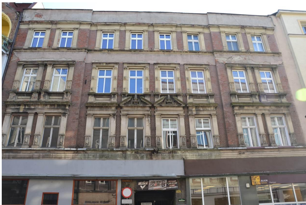
Rys. nr 2. Widok elewacji północno-zachodniej budynku przy ul. Dworcowej 31 w Bytomiu – elewacja frontowa [1.3].
