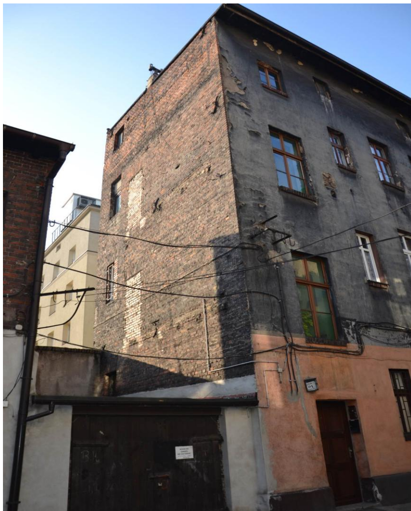
Rys. nr 7. Widok elewacji południowo-wschodniej budynku przy ul. Dworcowej 31 w Bytomiu – elewacja od strony podwórza [1.3.]
