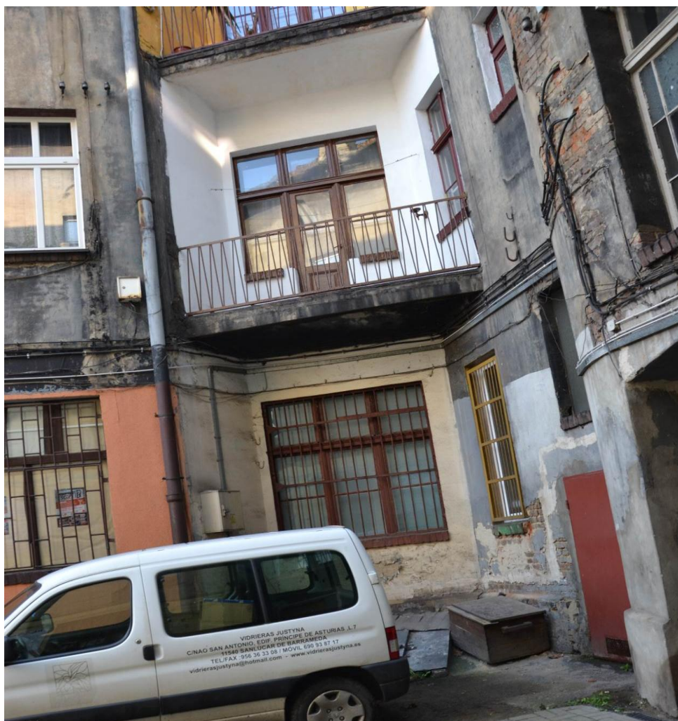
Rys. nr 21. Zacieki, odparzenia tynku, zabrudzenia korozyjne, znacznie wyeksploatowana stolarka okienna poddasza, ogniska korozji belek stalowych balkonów, brak odpowiedniej wysokości balustrady, korozja i wyeksploatowanie rury spustowej [1.3].
