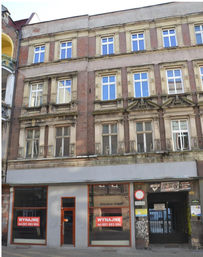
Rys. nr 3. Widok elewacji północno-zachodniej budynku przy ul. Dworcowej 31 w Bytomiu – elewacja frontowa [1.3.].
