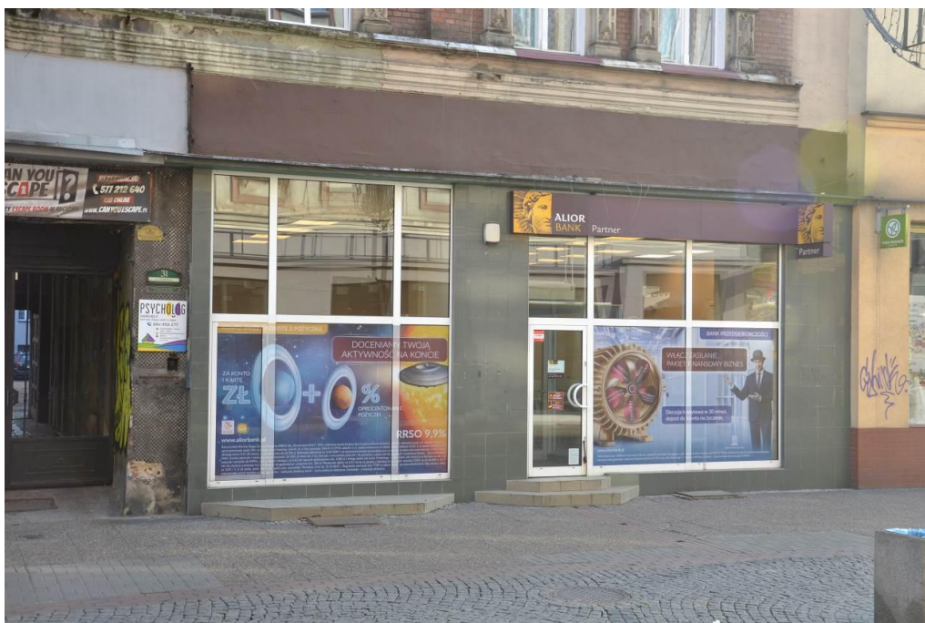
Rys. nr 5. Widok elewacji północno-zachodniej budynku przy ul. Dworcowej 31 w Bytomiu – elewacja frontowa, część usługowa [1.3].
