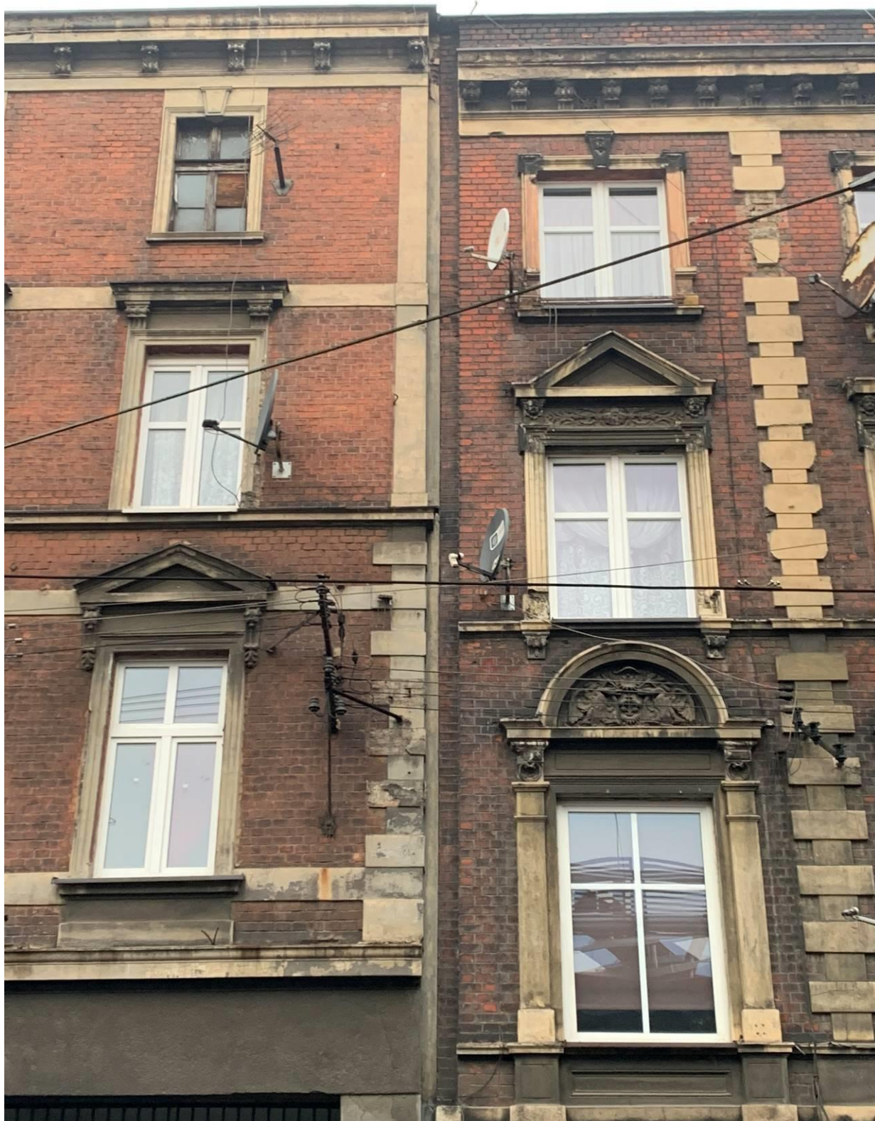
FOT.03. Elewacja wschodnia od strony nieruchomości sąsiedniej – strona prawa
