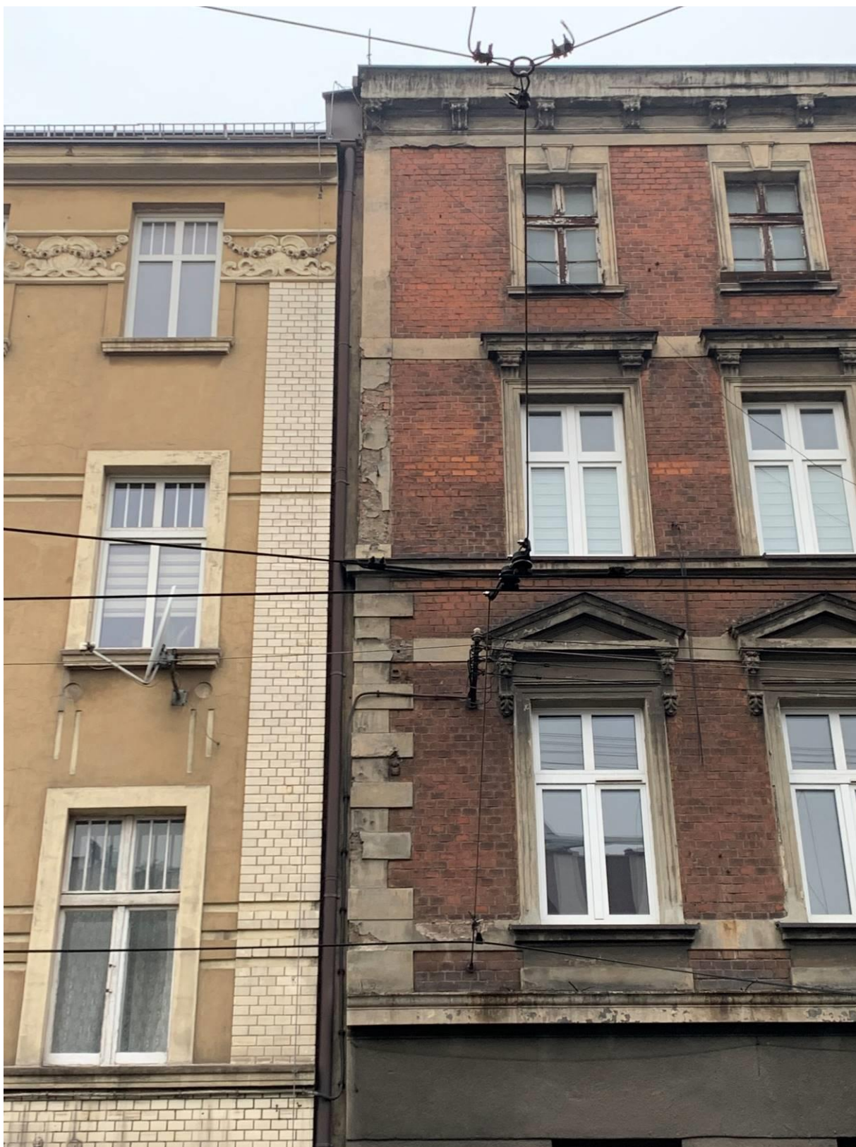
FOT.02. Elewacja wschodnia – od strony nieruchomości sąsiedniej (strona lewa)
