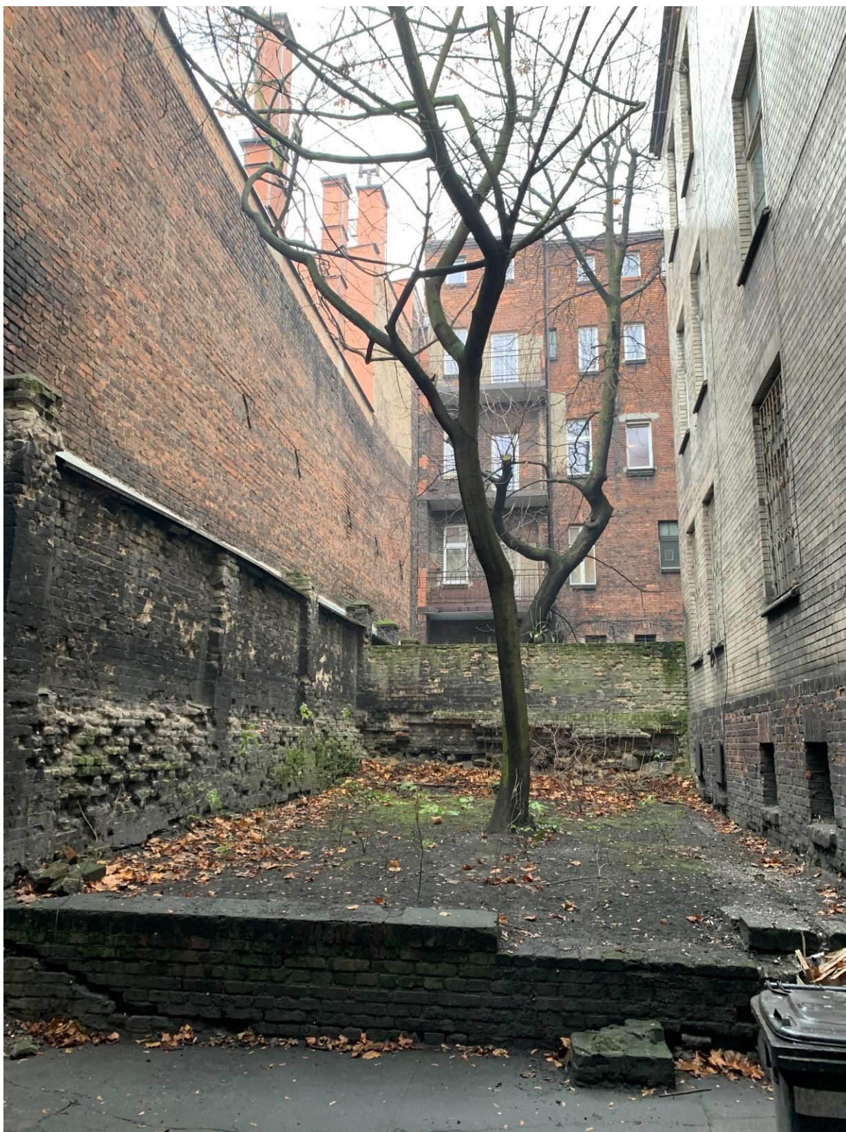
FOT.13. Widok na podwórze sąsiednie – działka nr 22, za murem 79/23 – ściany po lewej przeznaczone od ocieplenia ponad murem przy ścianie zewnętrznej
