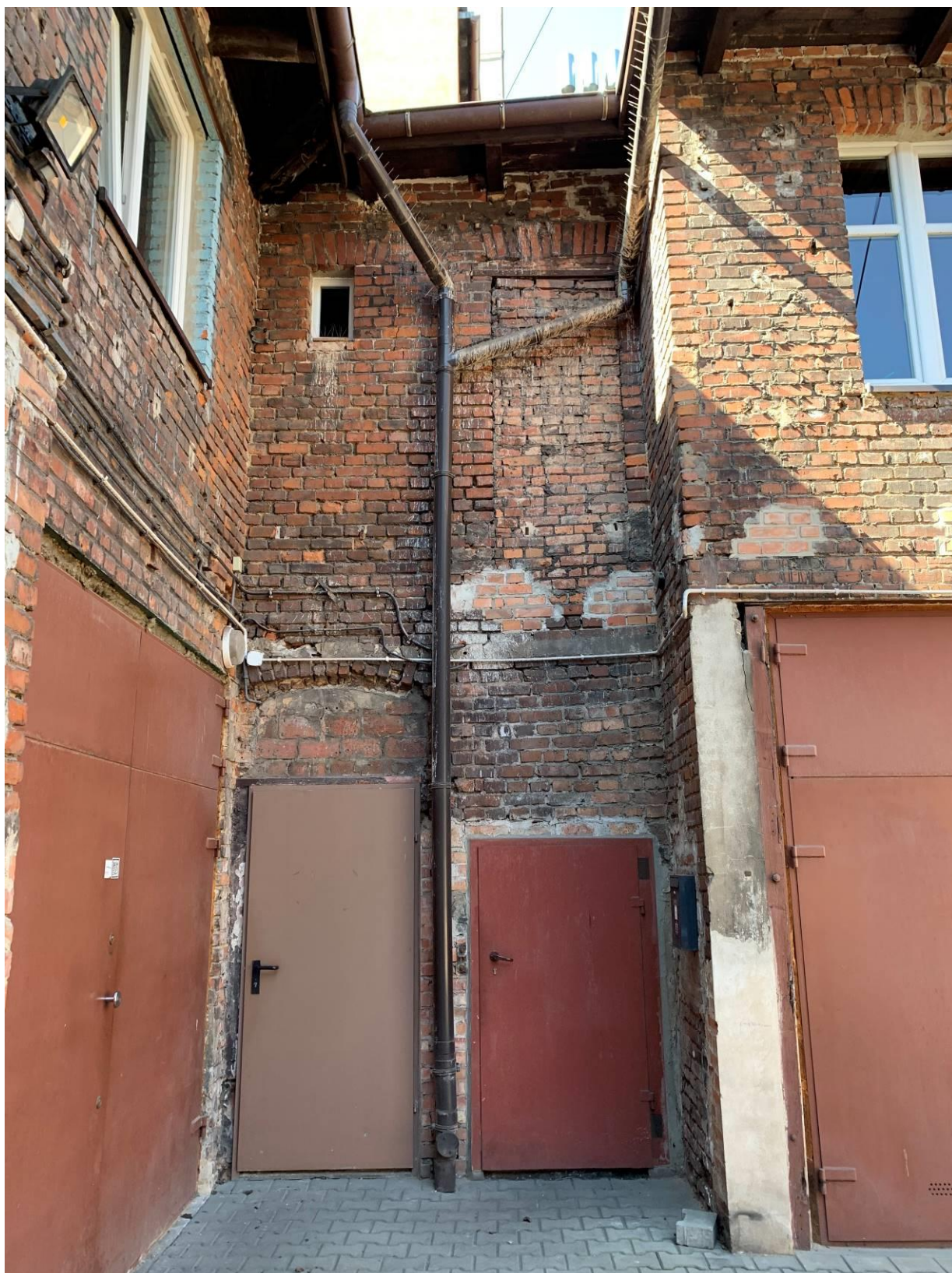
FOT.09. Widok ścian od strony podwórza
