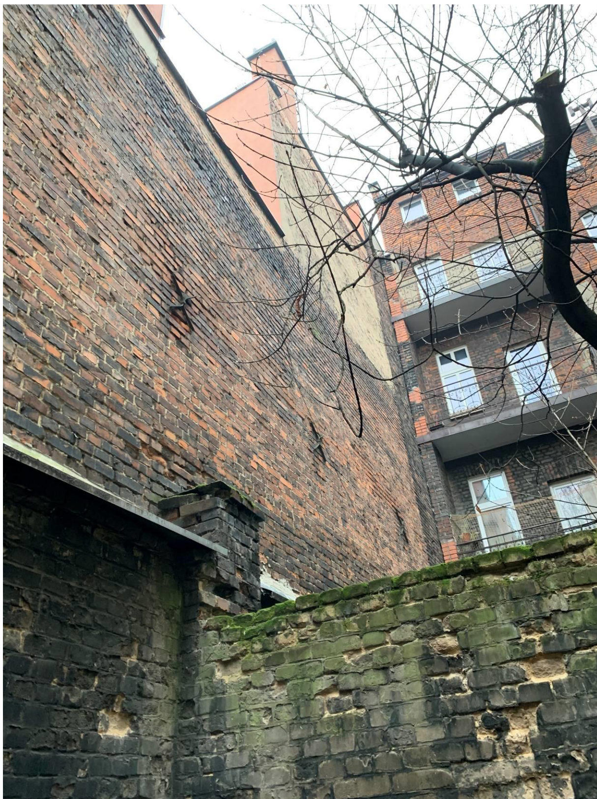
FOT.14. Ściany budynku przy ul. Jagiellońskiej 16 od strony działki nr 22 i 79/23
