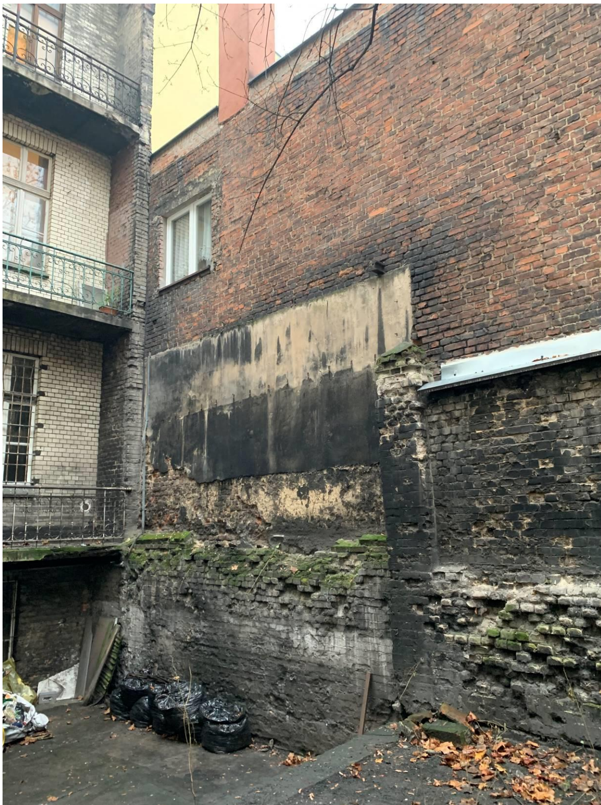
FOT.15. Ściany budynku przy ul. Jagiellońskiej 16 od strony działki sąsiedniej nr 22
