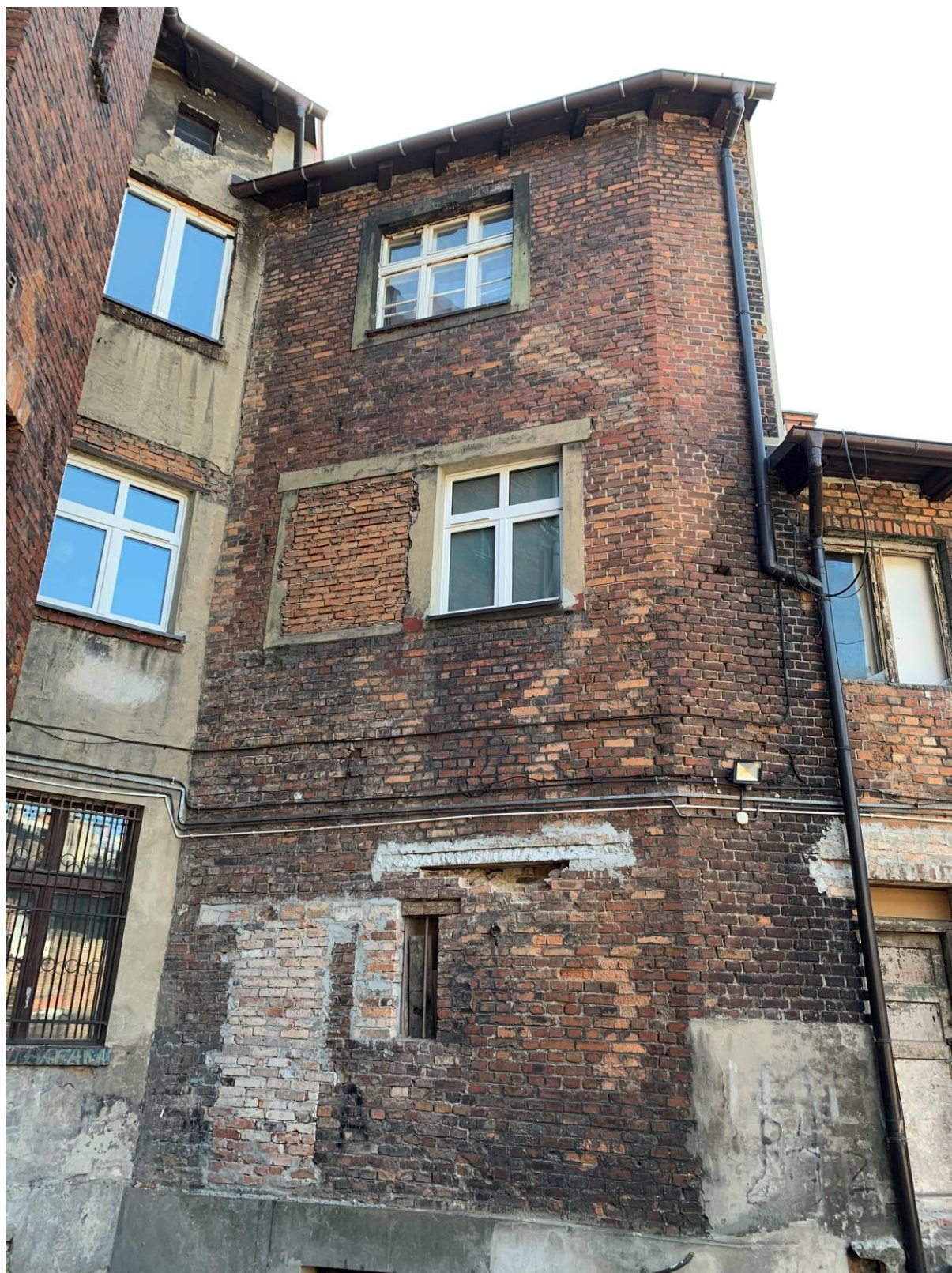
FOT.07. Widok ścian od strony podwórza
