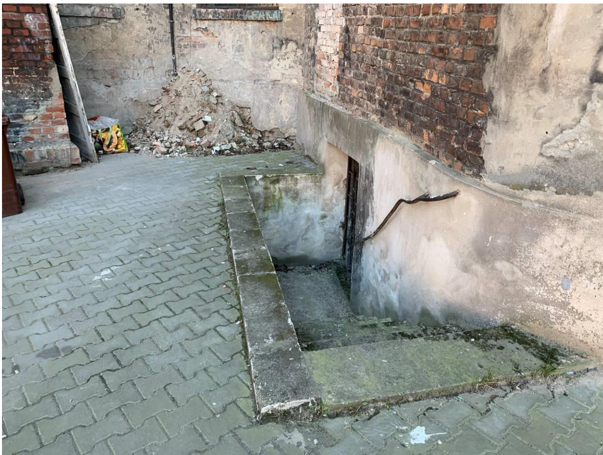
FOT.10. Schody do piwnic
