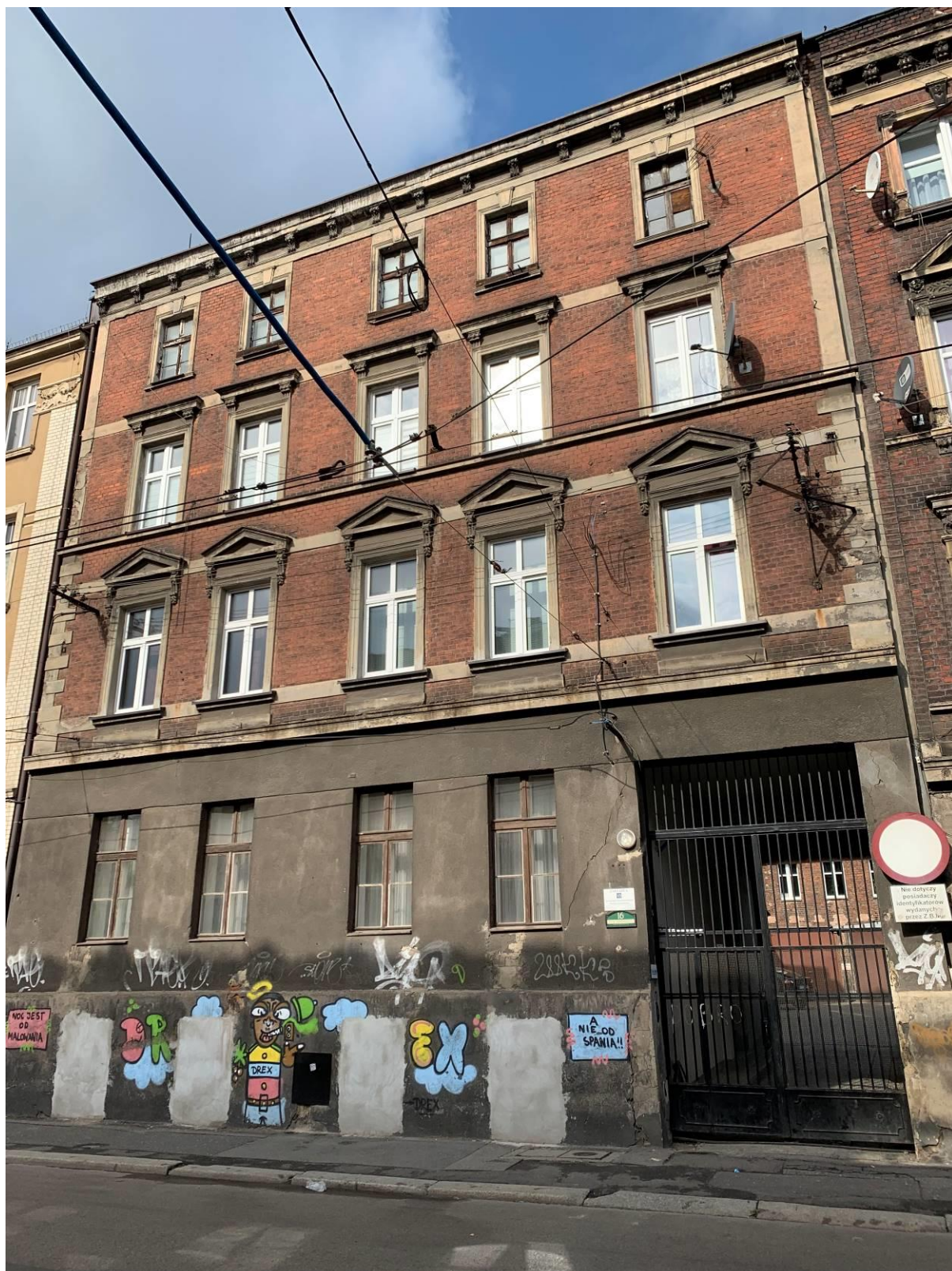
FOT.01. Elewacja frontowa budynku przy ul. Jagiellońskiej 16
