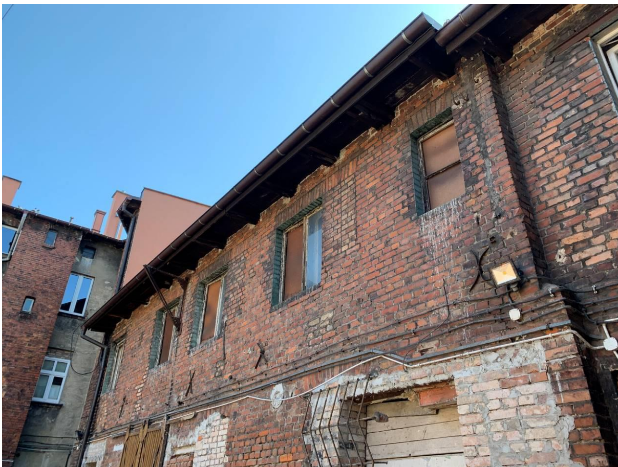
FOT.11. Widok ścian od strony podwórza
