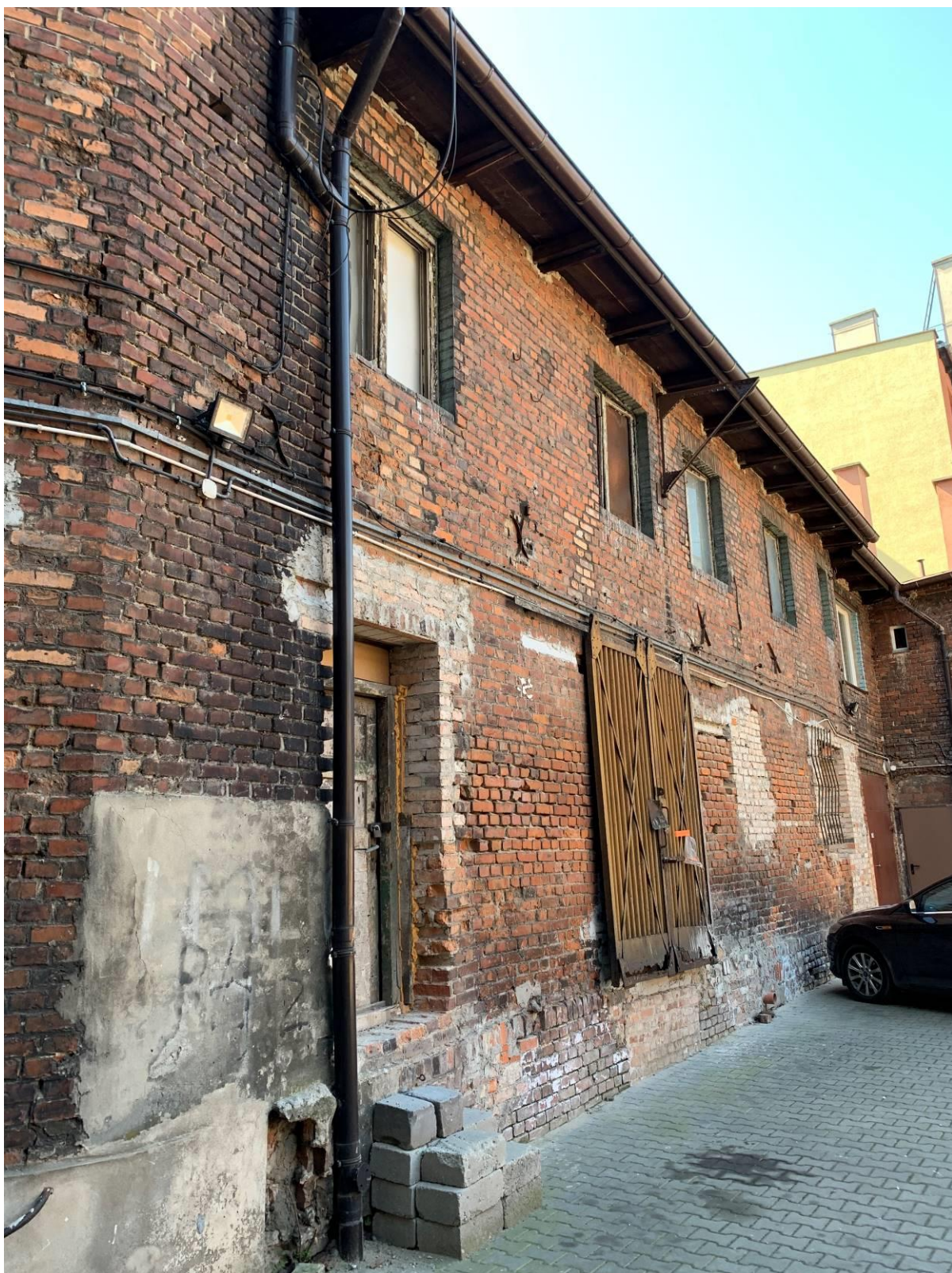
FOT.08. Widok ścian od strony podwórza - oficyna
