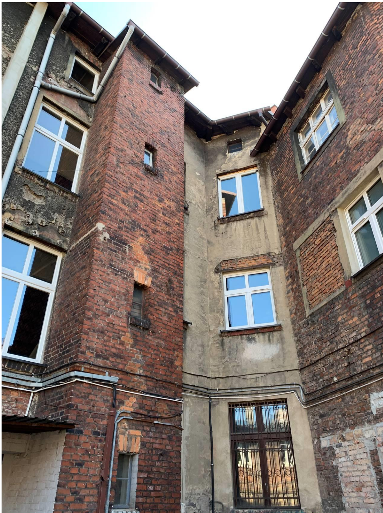
FOT.06. Widok ścian od strony podwórza
