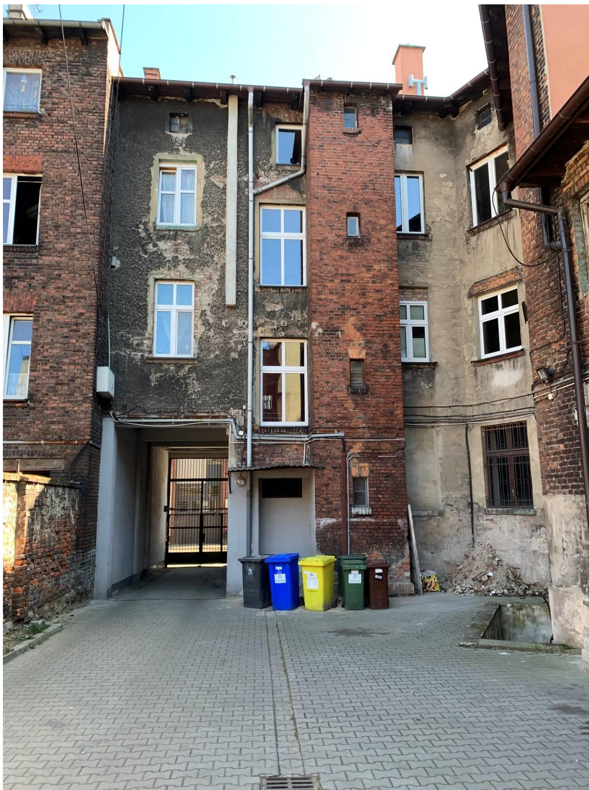
FOT.05. Ściany od strony podwórza
