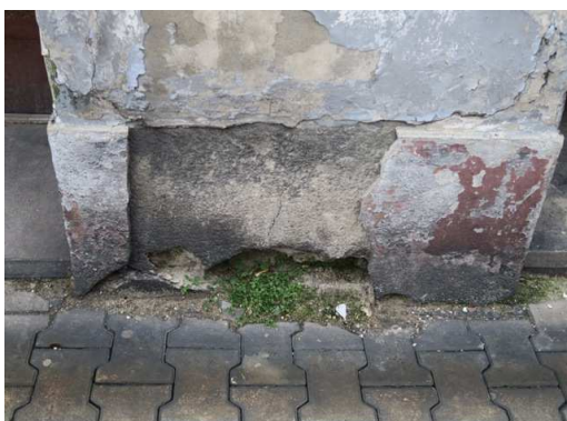
Widok uszkodzeń w strefie cokołowej budynku
