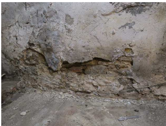
Widok uszkodzeń wywołanych działaniem soli budowlanych.
