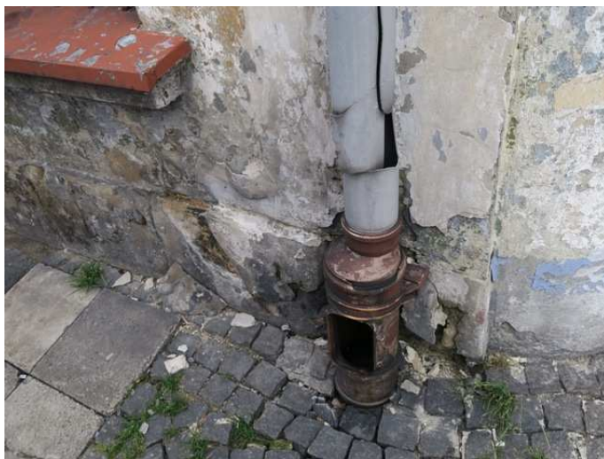
Stan odprowadzenia wód opadowych z dachu do kanalizacji deszczowej.
