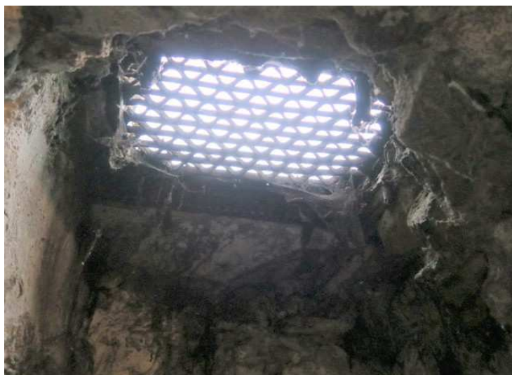
Widok jednego z otworów przy ścianie zewnętrznej
