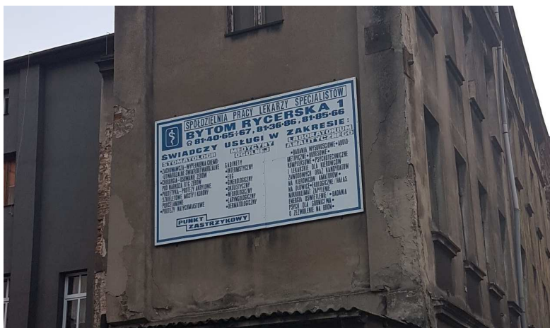
Widok elewacji z tablicą informacyjną
