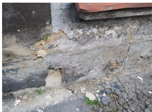
Widok uszkodzeń w strefie cokołowej budynku
