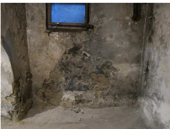
Widok uszkodzeń wywołanych działaniem soli budowlanych.
