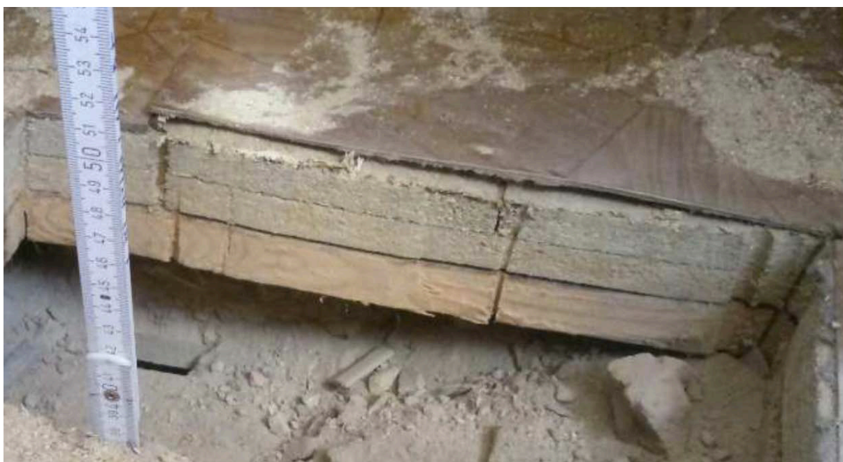
il. 3 - Warstwy podłogowe, ekspertyza budowlana
