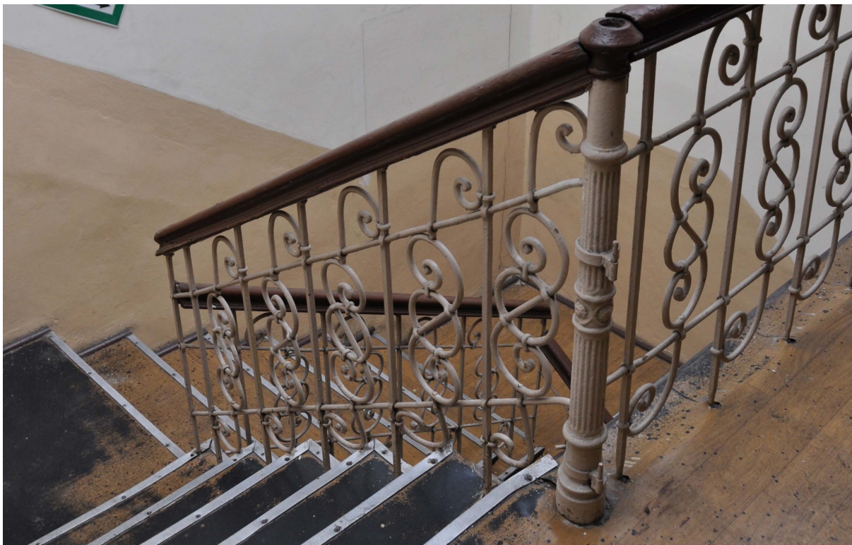
il. 18 - Widok klatki schodowej z drugiego piętra, materiały własne
