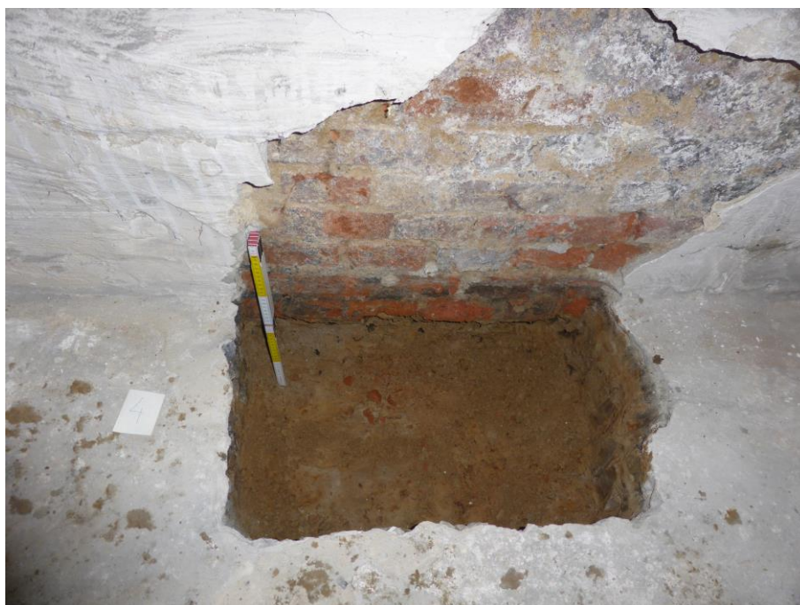
Fot. 7. Odkrywka nr 4. Foto od strony W
