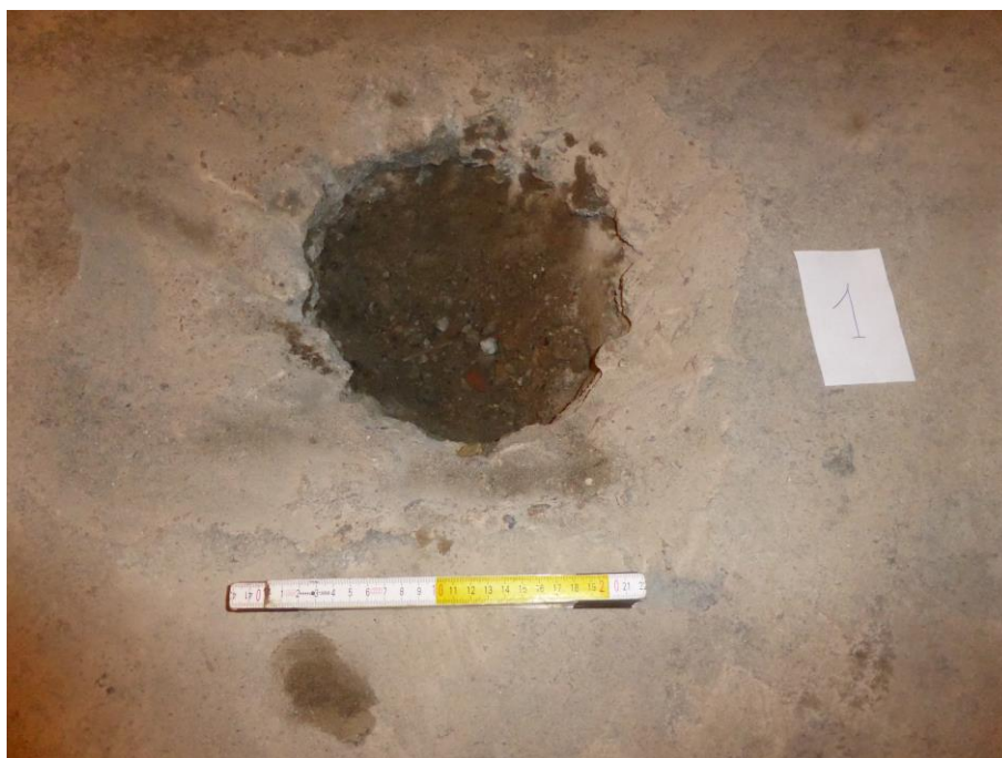
Fot. 13. Miejsce przygotowane pod odwiert nr 1. Foto od strony E
