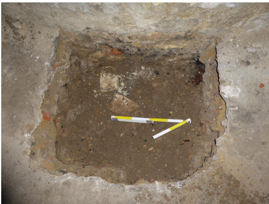
Fot. 12. Odkrywka nr 6. Kamienie na gł. 0,30-0,40 m
