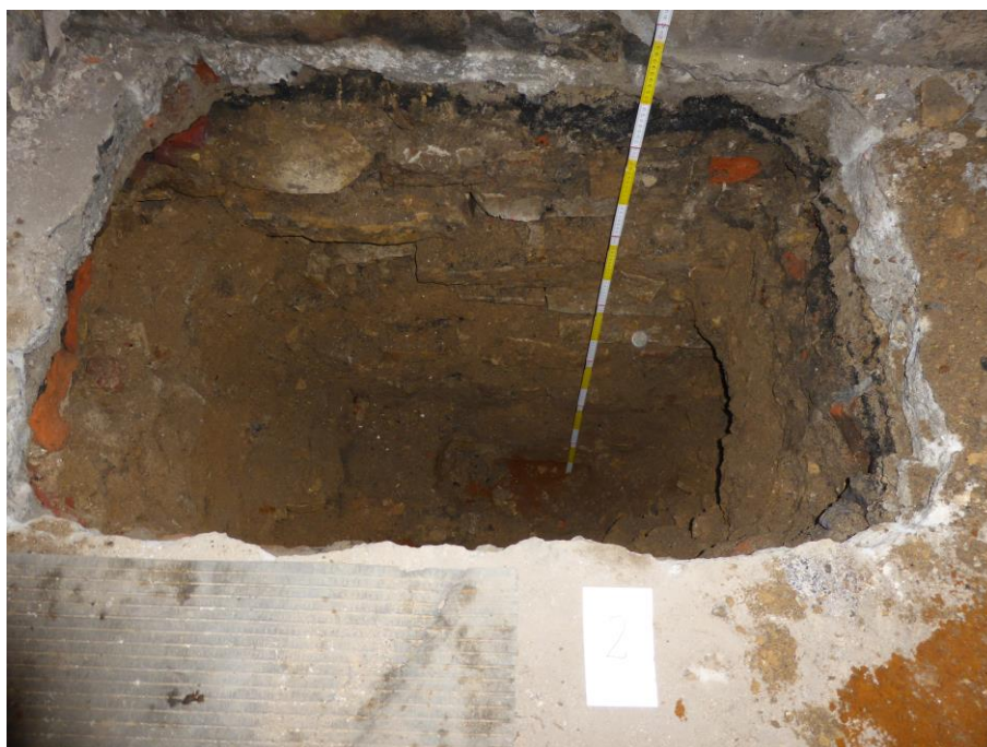
Fot. 3. Odkrywka nr 2. Foto od strony E
