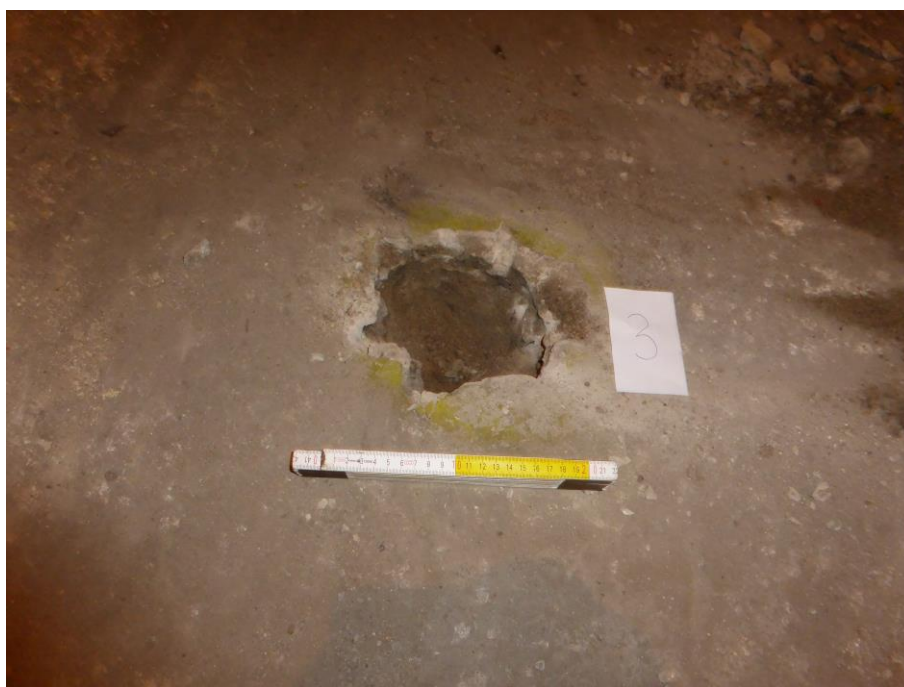
Fot. 15. Miejsce przygotowane pod odwiert nr 3. Foto od strony S
