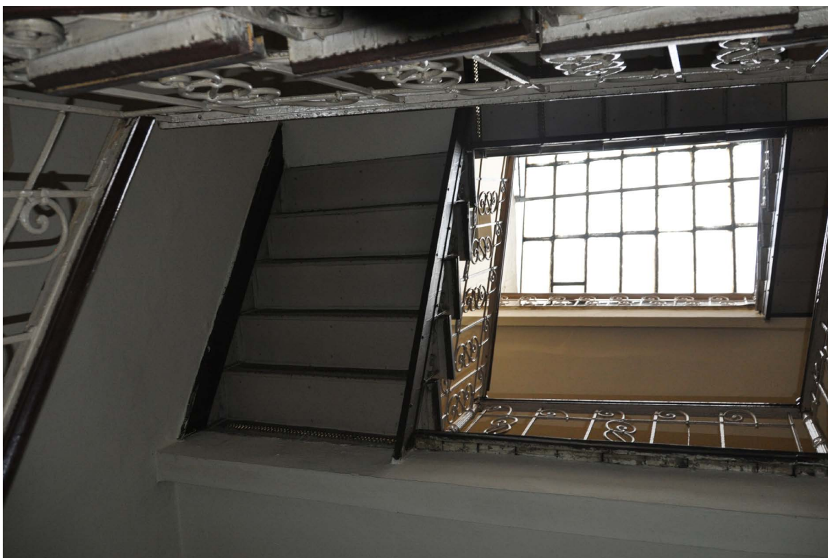
il. 19 - Widok klatki schodowej z parteru w stronę świetlika, materiały własne
