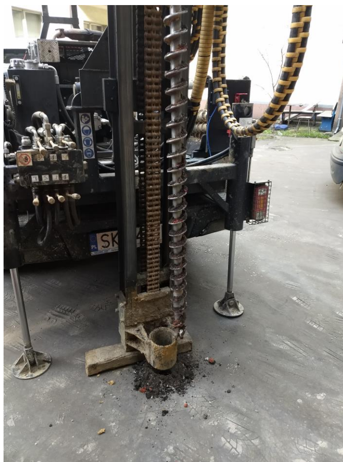
Fot. 16. Realizacja odwiertu nr 4. Foto od strony NW
