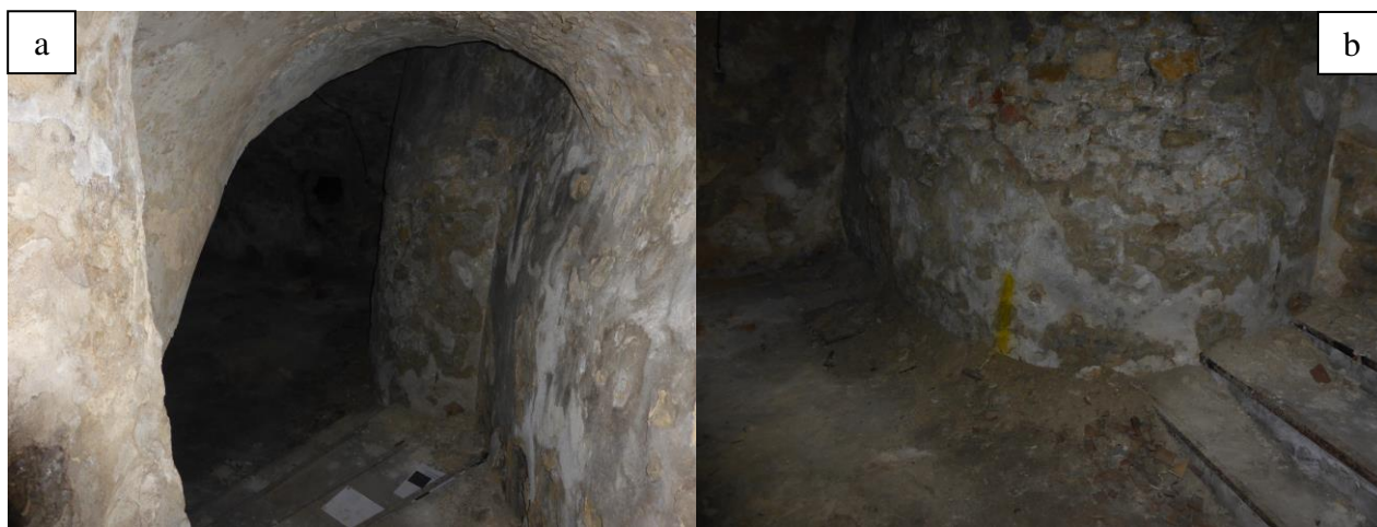
Ryc. 4. Bytom, ul. Rycerska 1. Zejście do najniżej położonego pomieszczenia piwnicznego (a) i kamienna ściana z zaznaczonym na żółto miejscem dodatkowej odkrywki nr 6 (b)
