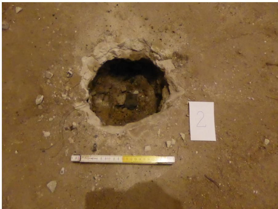
Fot. 14. Miejsce przygotowane pod odwiert nr 2. Foto od strony S
